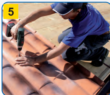
КРЕПЛЕНИЕ ПРИ ПОМОЩИ ВИНТОВ
